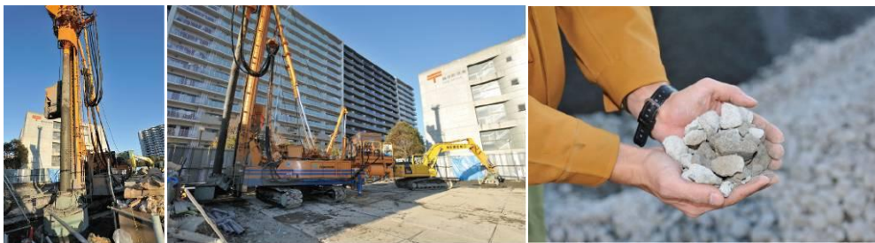
計画地の工事風景(平成23年12月撮影)
