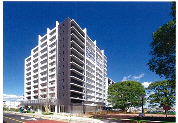
建物外観写真
