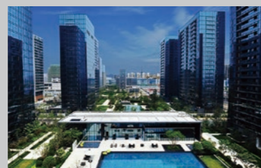
東部新城プロジェクト(寧波中心) (中国・寧波) 中国寧波市が推進中の新都市開発エリア(約1,600ha)に位置する、大規模複合開発。寧波市の新ランドマークプロジェクト。
